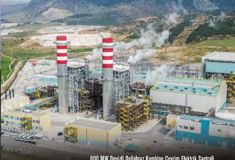
800 MW Denizli Doğalgaz Kombine Çevrim Elektrik Santrali RWE & Turcas Güney Elektrik Üretim A.Ş.
