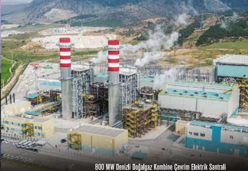
800 MW Denizli Doğalgaz Kombine Çevrim Elektrik Santrali RWE & Turcas Güney Elektrik Üretim A.Ş.
